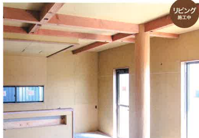
▲家をしっかりと支えてくれる存在感抜群の杉丸太の柱！リビングは梁も見えて素敵な空間に。
